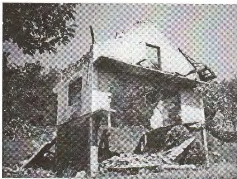
Uništene stambene kuće u selu Gora
